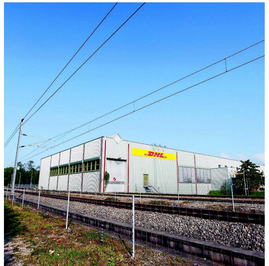
DHL will auf dem Schoeller-Areal bauen. HANSPETER BÄRTSCHI
